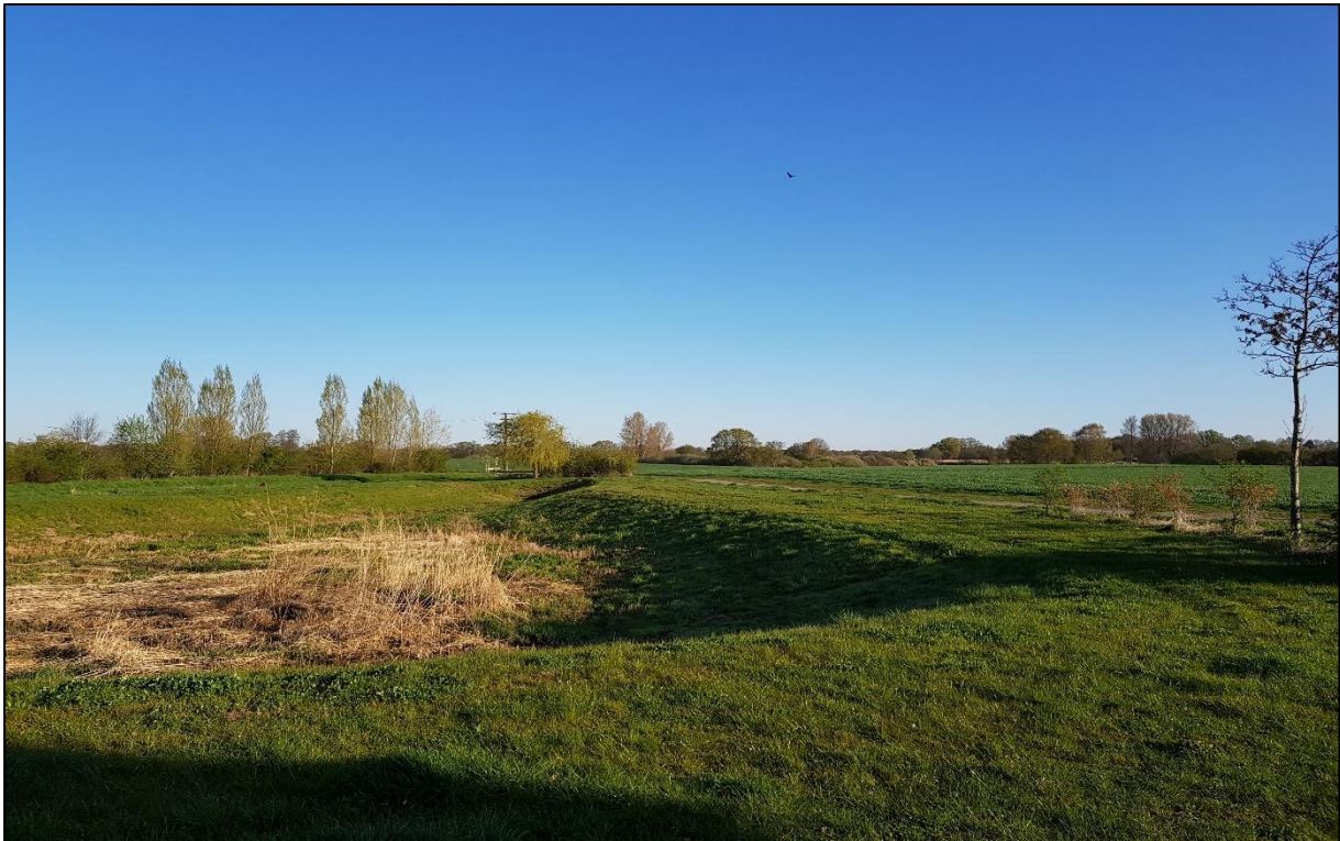
Abbildung 4: Regenrückhaltebecken südwestlich des Plangebietes
